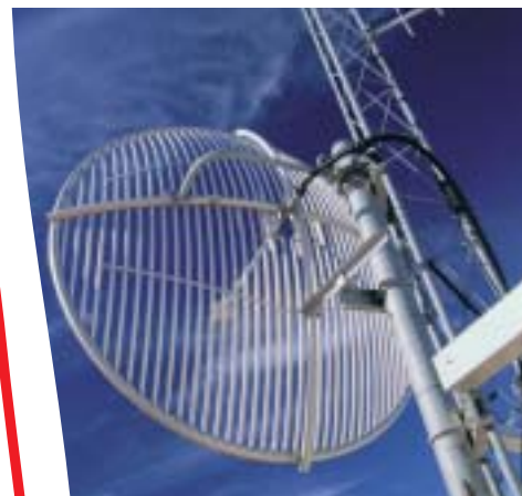
Sistema a prueba de fallos, con redundancia, capacidad de evolución y alta calidad de la energía eléctrica.
